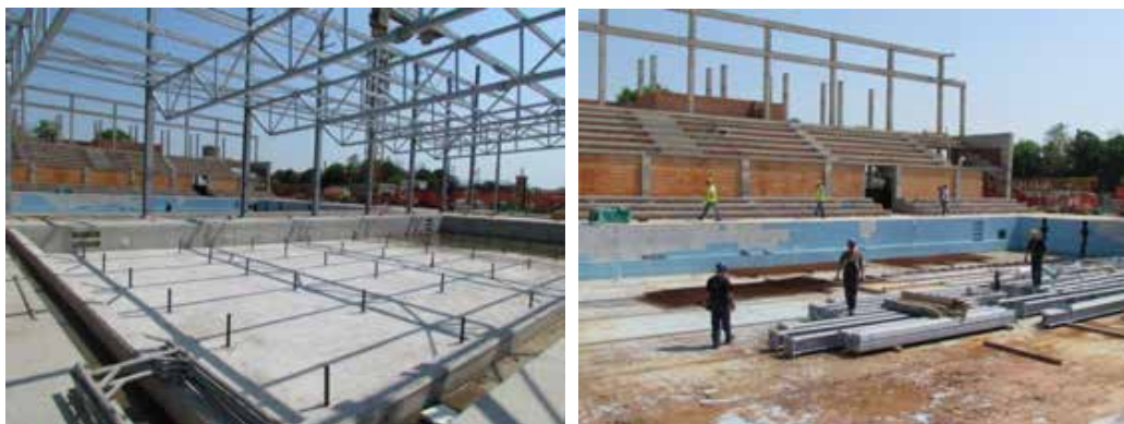
Слика 9— Радови на изградњи градског базена у Шапцу
