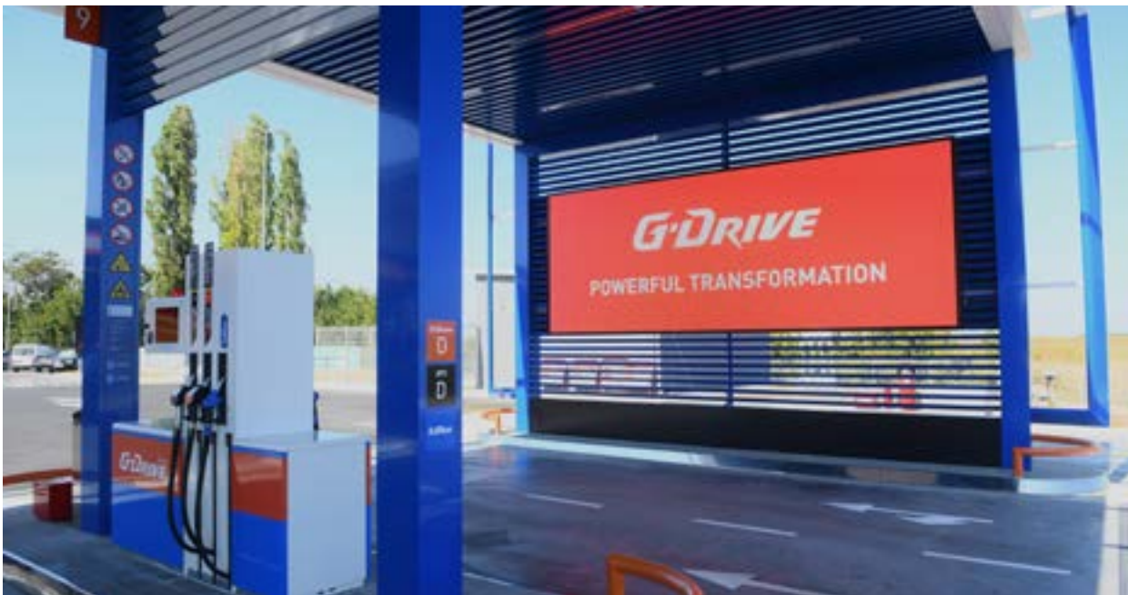
Нови формат GAZPROM станице за снабдевање горивом
